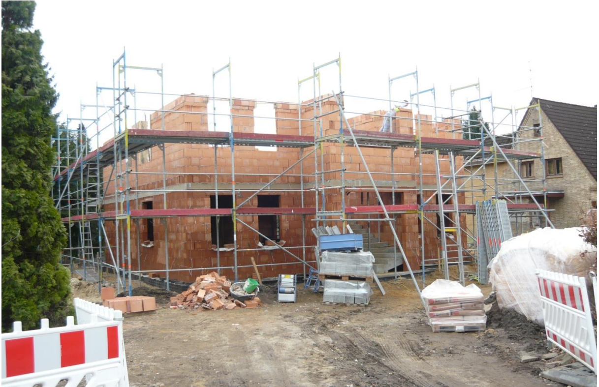
Rohbau nach Fertigstellung der Maurerarbeiten
