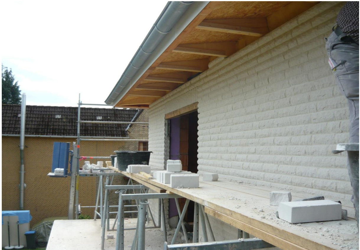
Verblendmauerwerk während der Ausführung
