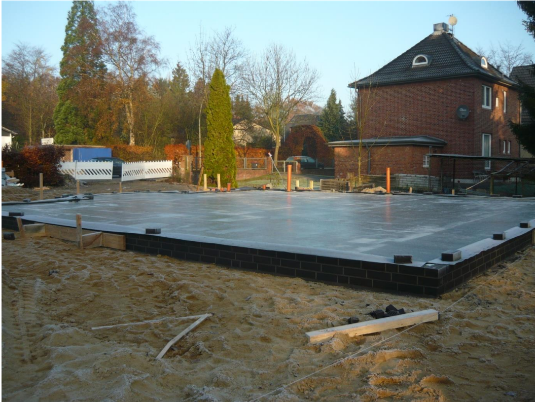
Bodenplatte nach den Betonierarbeiten
