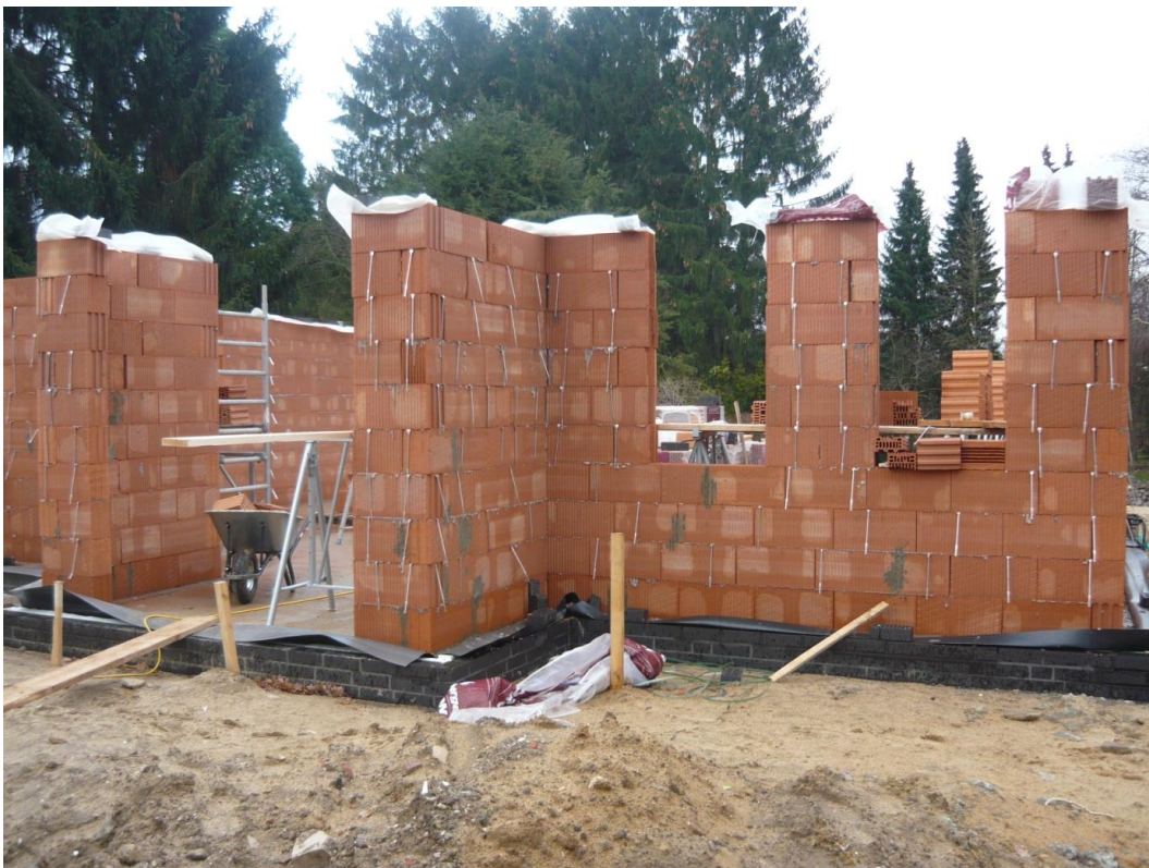
Erdgeschossaußenwände aus Poroton-Planziegeln
