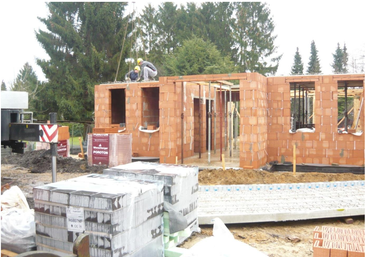
Verlegen der Fertigteildecke
