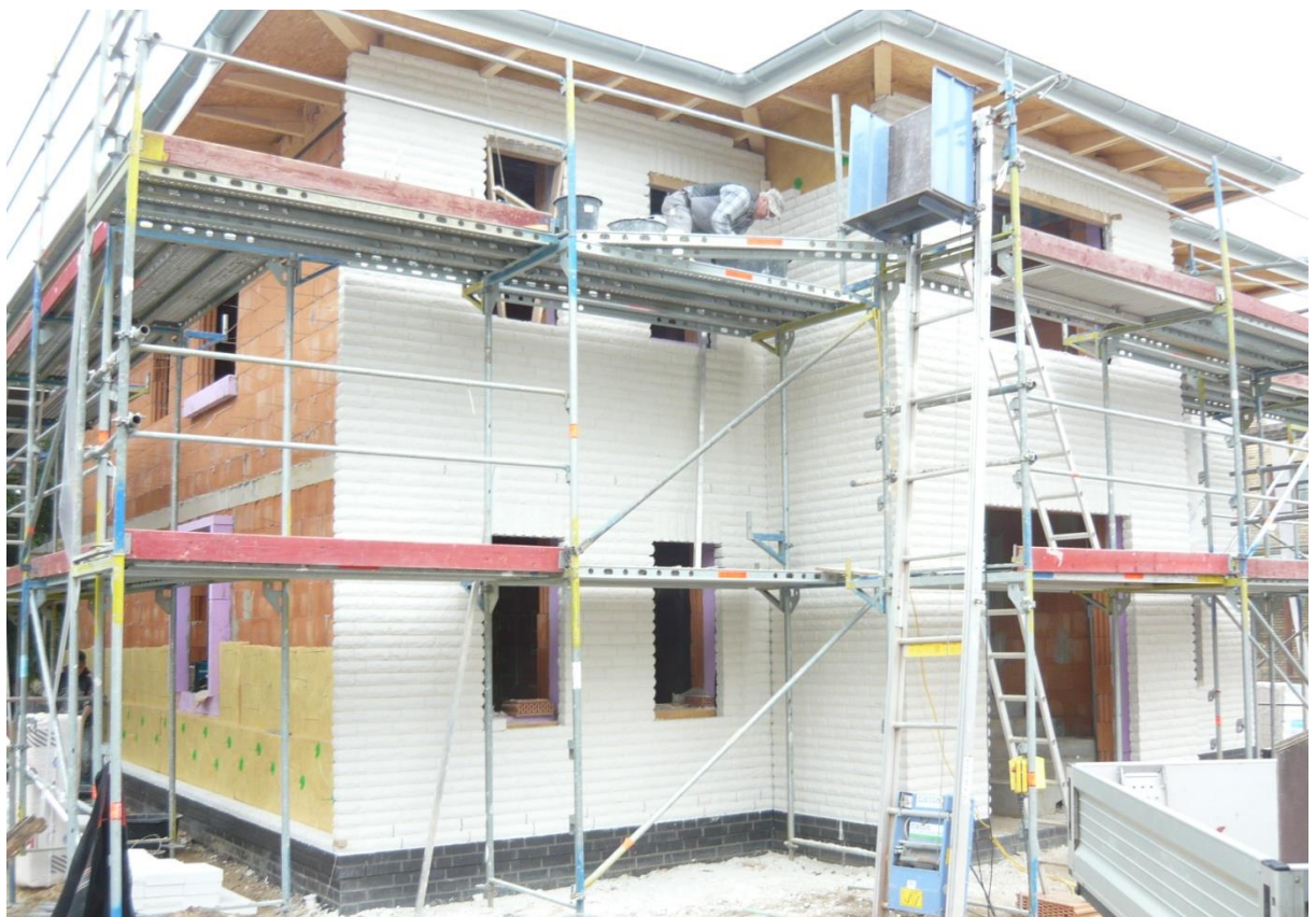
Verblendmauerwerk während der Ausführung
