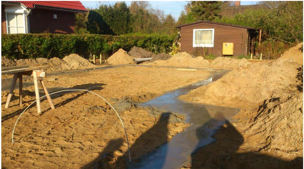
Streifenfundamente nach Betonierung
