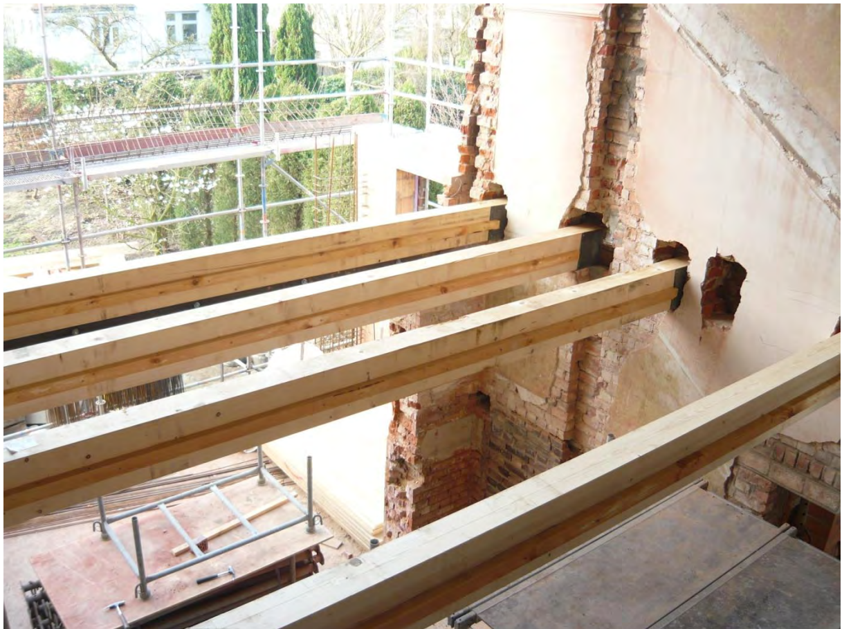
Einabu von neuen Deckenbalken in den Geschossen
