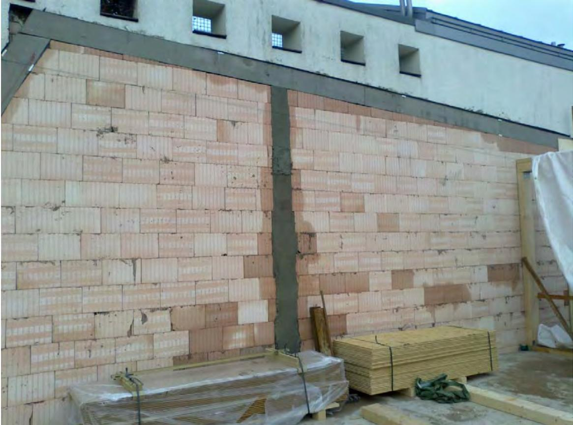
Neu erstellte Brandwände im DG aus Poroton-Planziegeln
