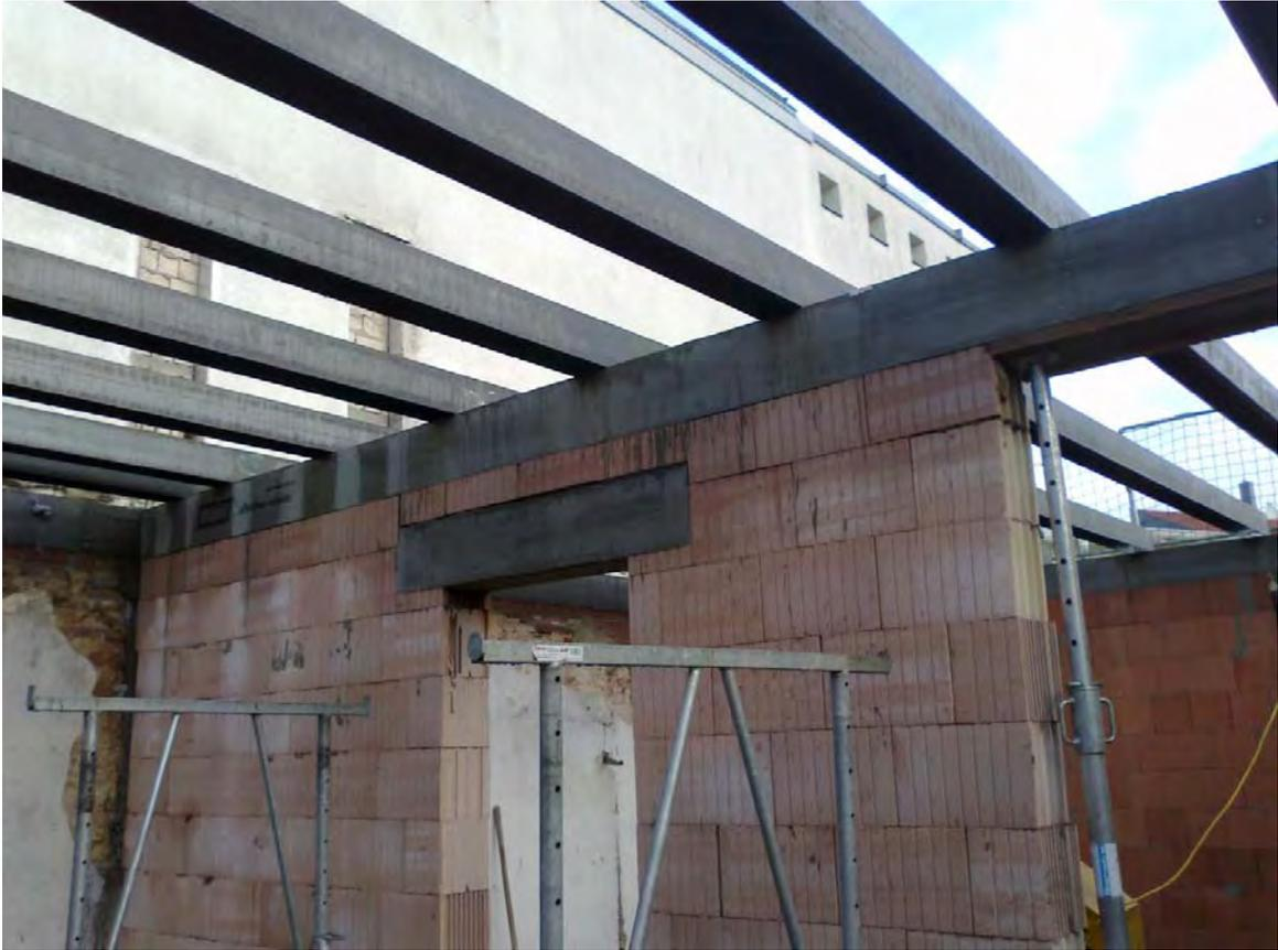
Stahlträgerdecke auf umlaufenden Stahlbeton-Ringbalken
