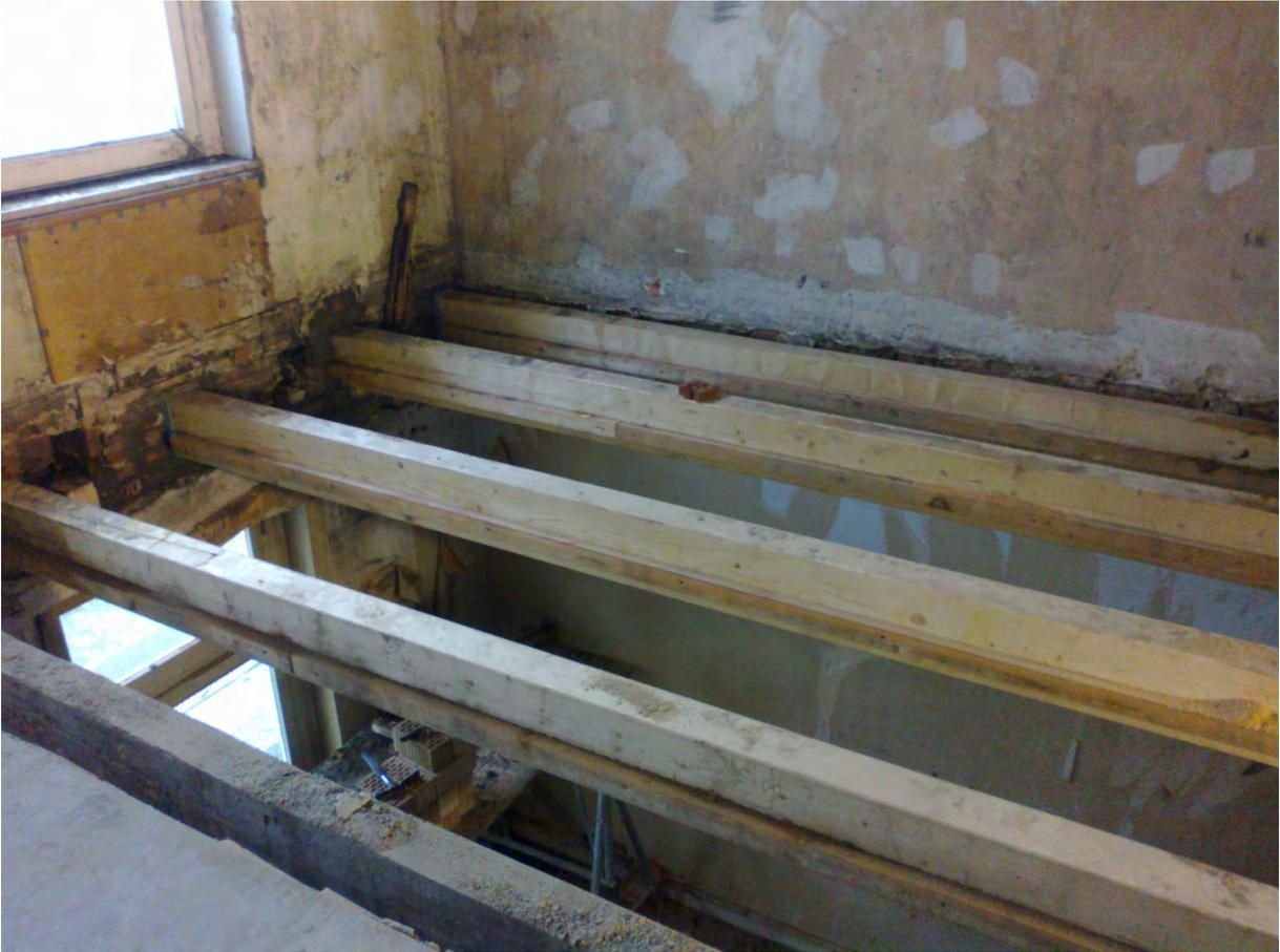
Neu eingebaute Deckenbalken der Geschosdecken
