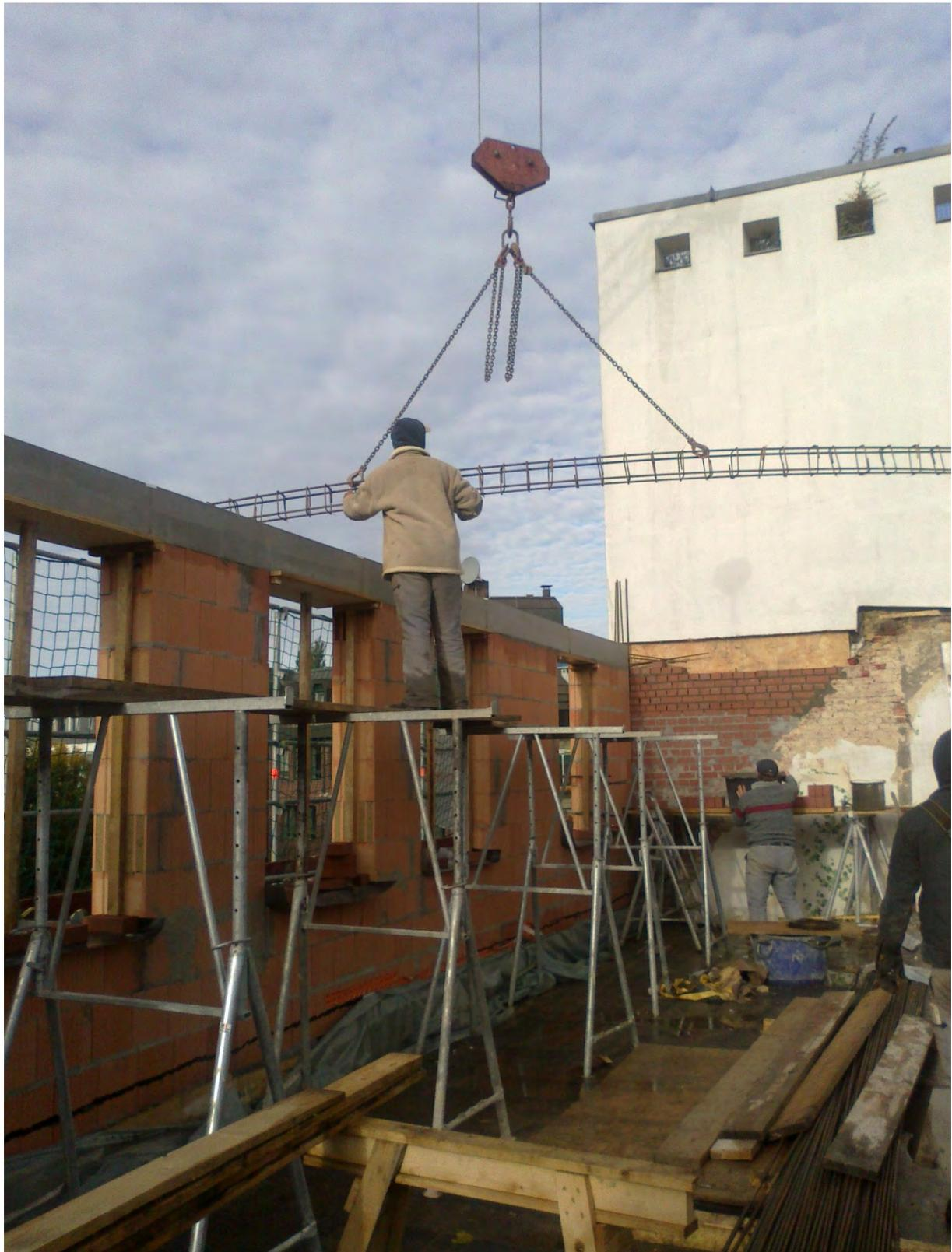
Bewehrung für Ringbalken der Außenwände
