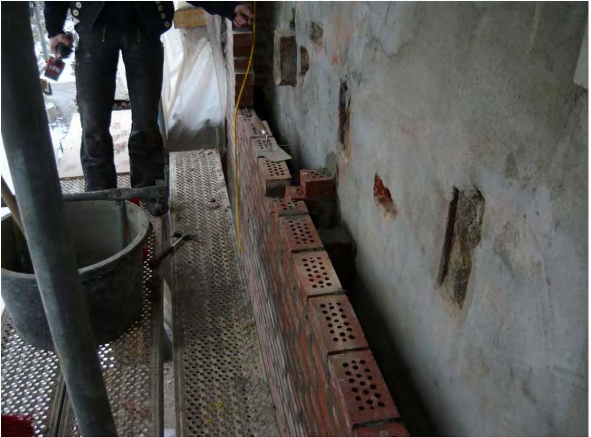
Neu hergestelltes Gieblaußenmauerwerk aus kleinformatigen Mauerziegeln
