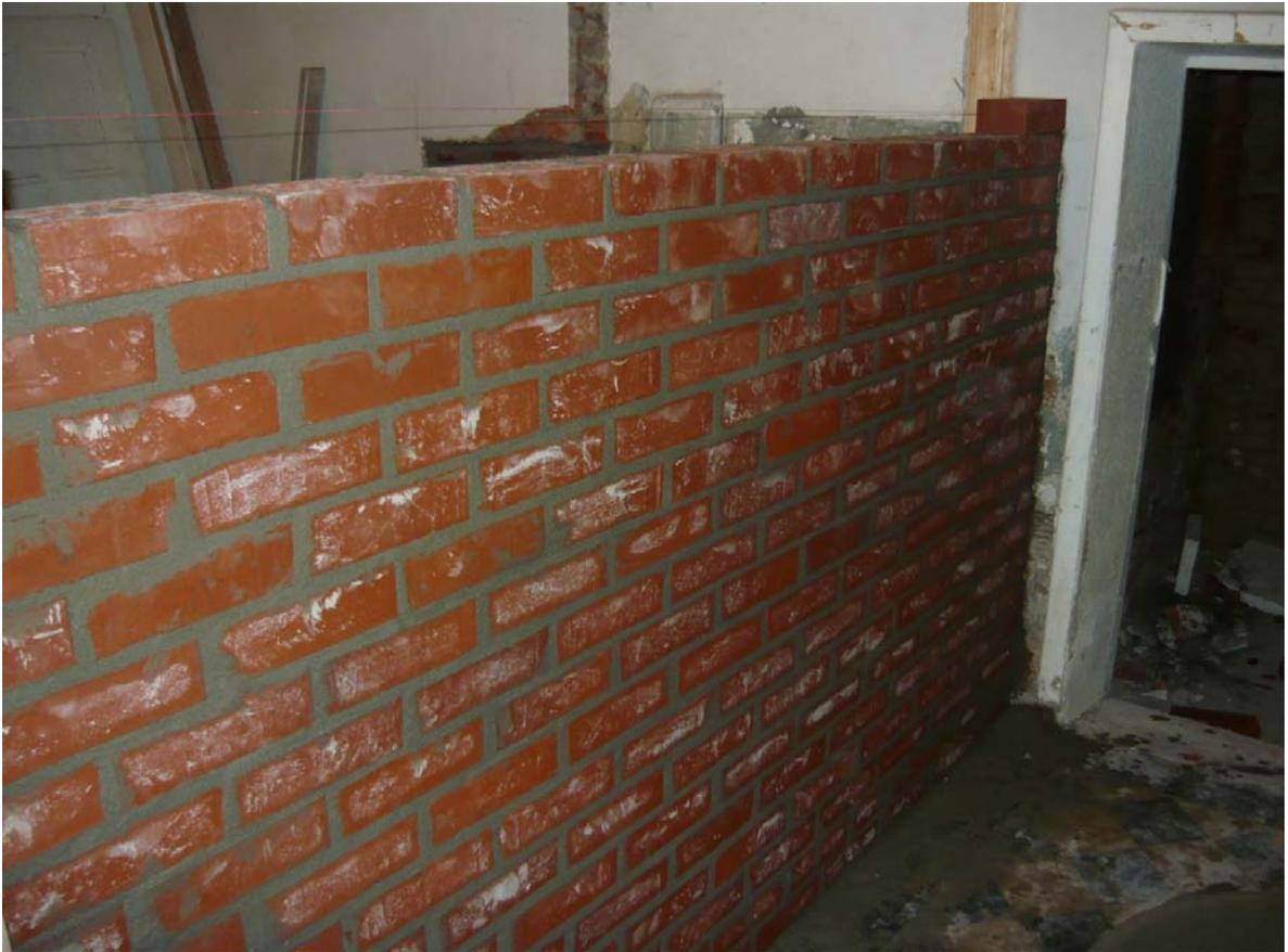
Neu erstellte Innenwände aus kleinformatigen Mauerziegeln
