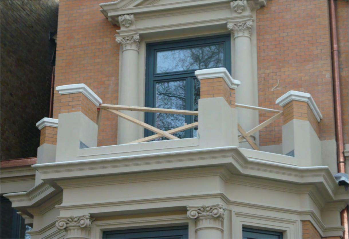
Neu erstellte Mauerwerkspfeiler auf dem vorderen Balkon
